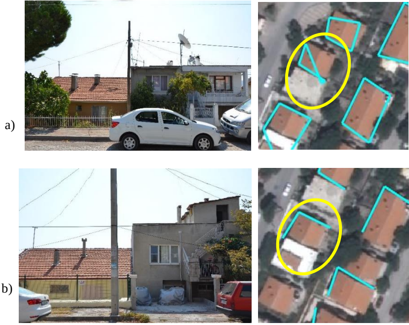
Şekil 10: a) Farklı yükseklik ve çatı maddelerine sahip bitişik nizamlı binalar ve doğru çatılamayan bina sınırları, b) Bina üzerindeki ek kattan dolayı doğru çatılamayan bina sınırı
