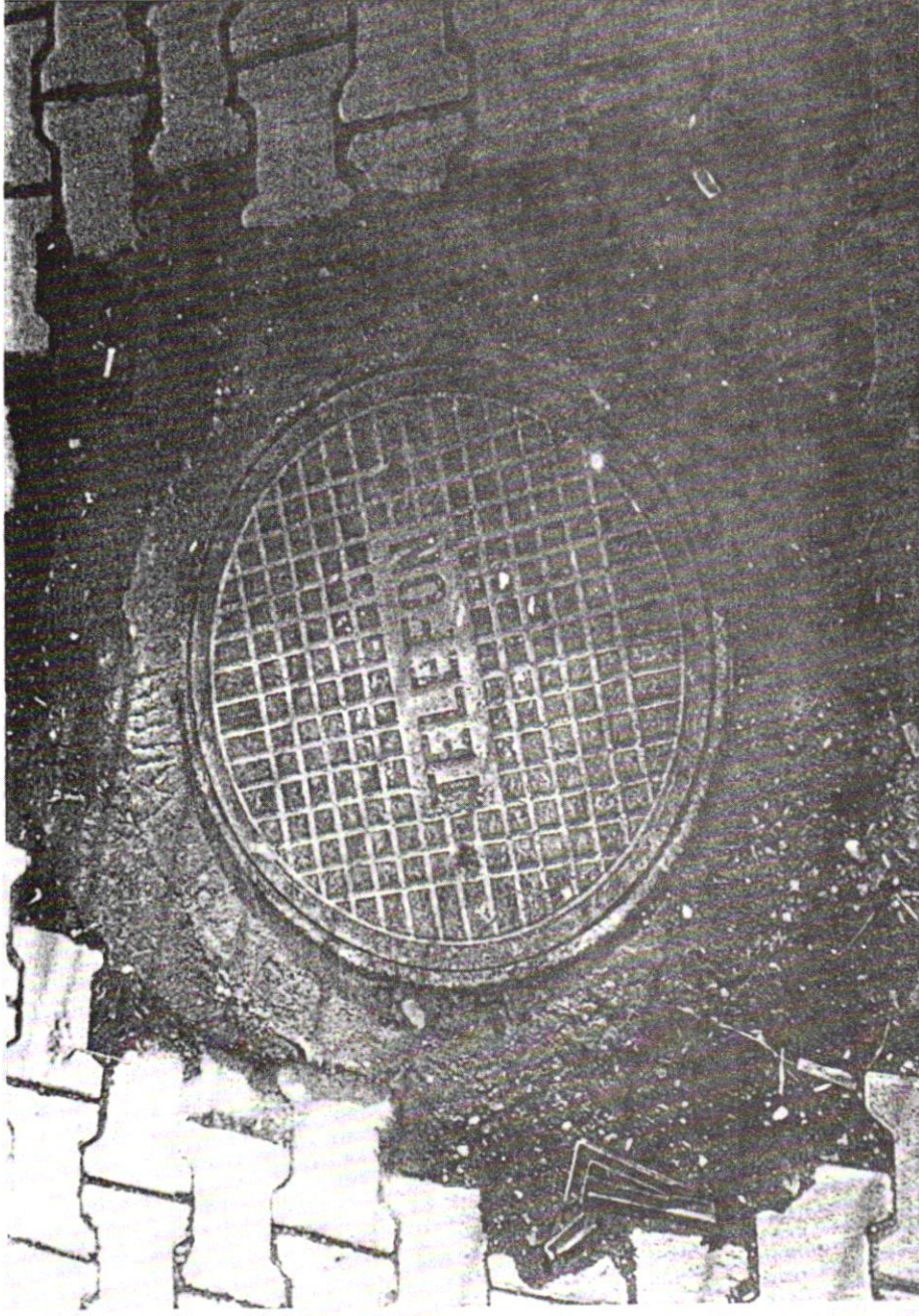
2.6. Telefon hatları ve gardımcı tesisleri. (Hıyazene bacası)
